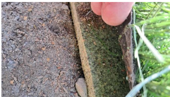
Kuva 30. Pajamäen lämmitettävän kentän tekonurmen joustokerros.
