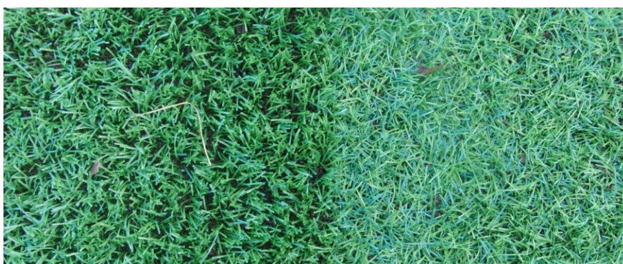
Kuva 36. Ikurin jalkapallokentän (26.8.2024) pintaa. Vasemmalla kentän uusittu tekonurmi, jossa nukka on pystyssä, ja oikealla alkuperäinen tekonurmi nukka taittuneena.
