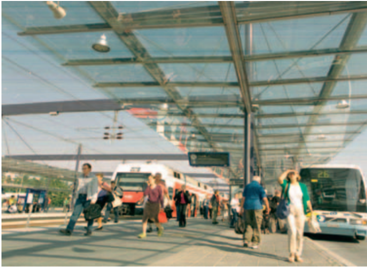
Junamatkojen määrä kasvoi viime vuonna sekä kaukojunissa että pääkaupunkiseudun lähiliikenteessä. Junissa tehtiin kaikkiaan ennätyselliset 63,5 miljoonaa matkaa. Kaukojunissa matkojen määrä lisääntyi 3,1 % ja lähijunissa 6,2 %.
