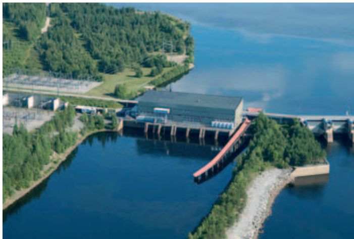
Valajaskosken voimalaitoksella kolmen vuoden aikana suoritettu tehonnosto- ja peruskorjausprojekti päättyi. Samanaikaisesti perattiin Valajaskosken alapuolista jokiuomaa. Näiden hankkeiden myötä vuonna 1960 rakennetun laitoksen teho nousi 40 prosenttia.
