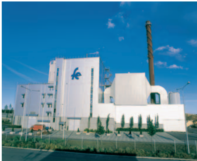
Forssan voimalaitos käyttää paikallisia biopolttoaineita: puuta, turvetta ja kierrätyspolttoainetta.
